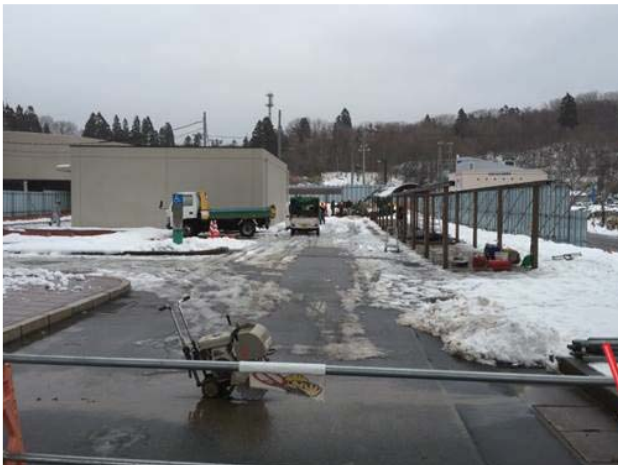
解体スタート時（平成28年2月18日）
