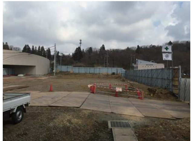
解体完了時（平成28年3月17日）
